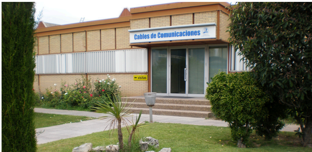
Ilustración 1. Fotografía Aérea instalaciones CABLESCOM
